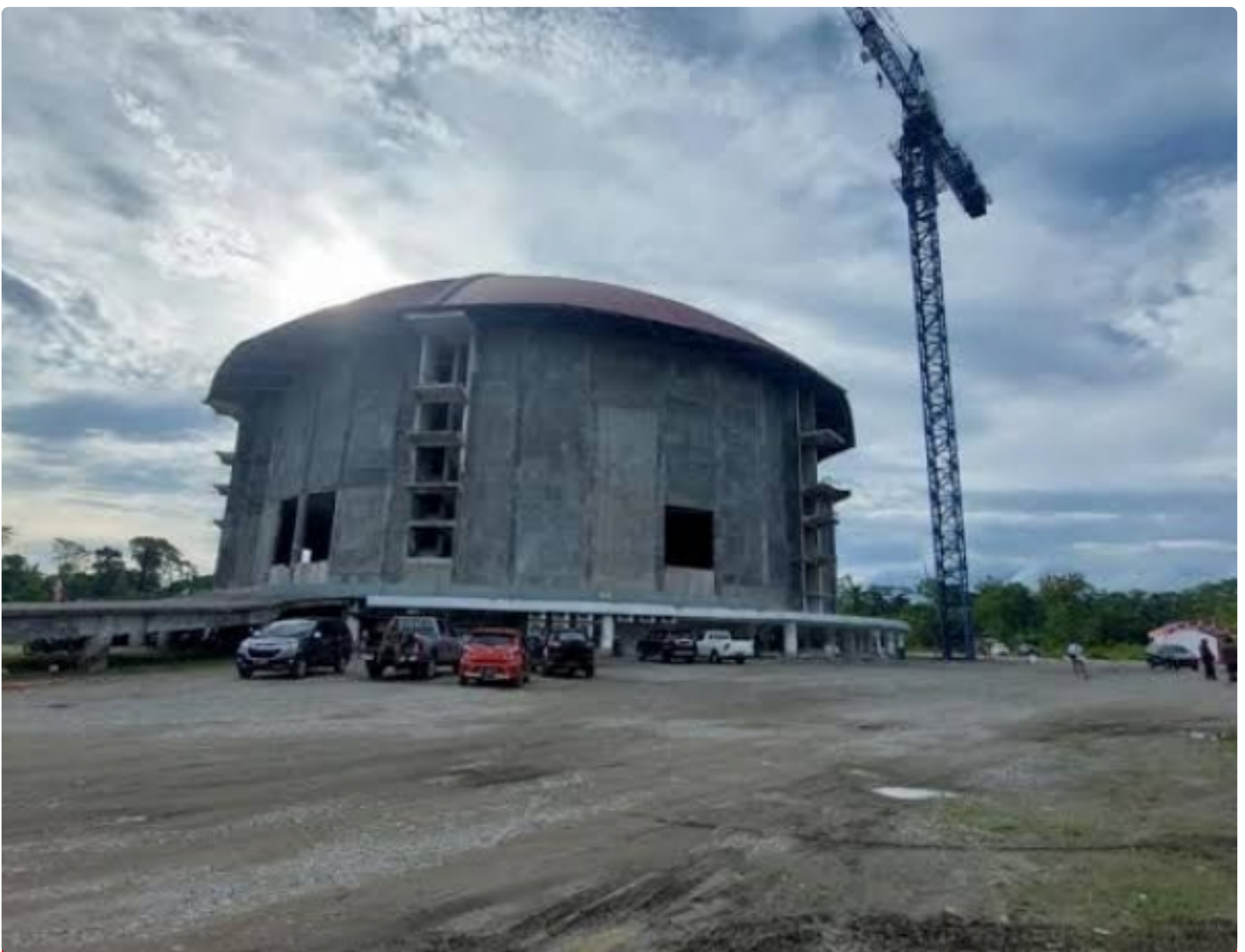
Pembangunan Gereja Kingmi Mile 32
